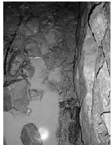
Das ständig herab tropfende Wasser bildet auf dem Lehm Boden des Knickganges Wasserlachen.
