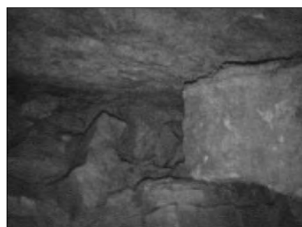
Die hintere Abschlussmauer stammt noch aus der Zeit der Errichtung der Kammer, bevor der Hügel aufgeschüttet wurde, denn sie wurde von außen angesetzt, wie die Details zeigen (oben: rechte Seite, Mitte: linke obere Seite, unten: rechte obere Seite)
